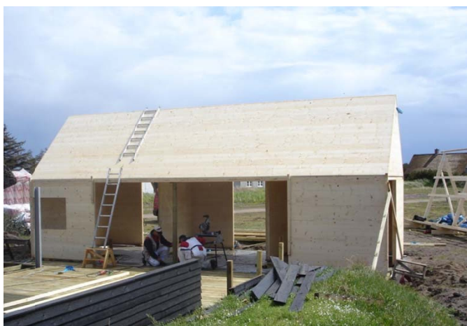
Eksempel på konstruktion i krydslimet massivtræ.
